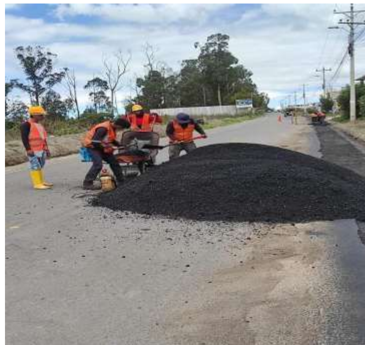
Asfaltado calle Quito de la parroquia de Malchinguí
