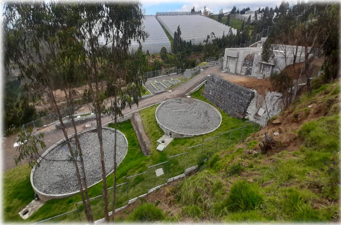
Planta de Tratamiento Comunidad Angumba
