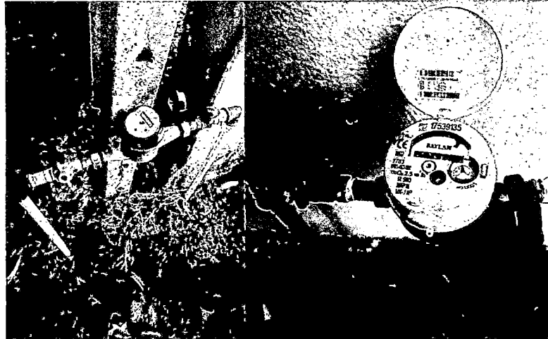
Ilustración 2: Micro medidores que abastecen de agua a las urbanizaciones.
