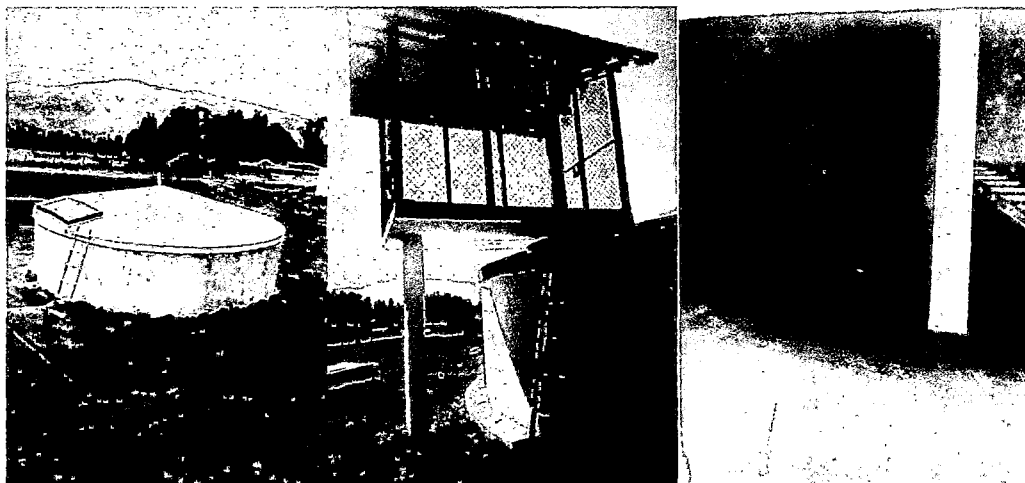
Ilustración 3: Tanque de reserva construido para la línea de conducción
